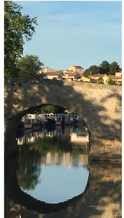
**F**inancés par les États du Languedoc, les ponts du canal du midi ont été construits en même temps que l'aménagement du canal afin de pouvoir le traverser. Les ponts du canal ont évolué dans leur forme et leur mode de construction. Situé au niveau du port de plaisance à Capestang, le pont de pierre, est l'œuvre des architectes Claude Collin et Pierre Launay. Construit entre 1688 et 1689, il est également appelé le pont de Saïsse, nom d'un ruisseau environnant.
