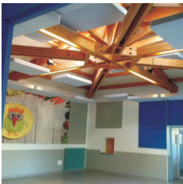
Insonorisation du restaurant scolaire
