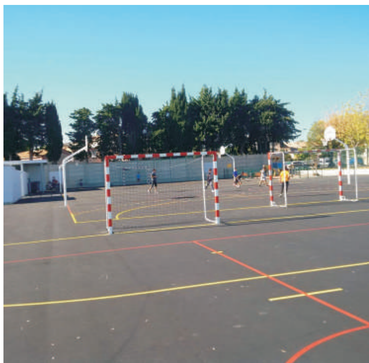
Réfection du plateau sportif du stade
