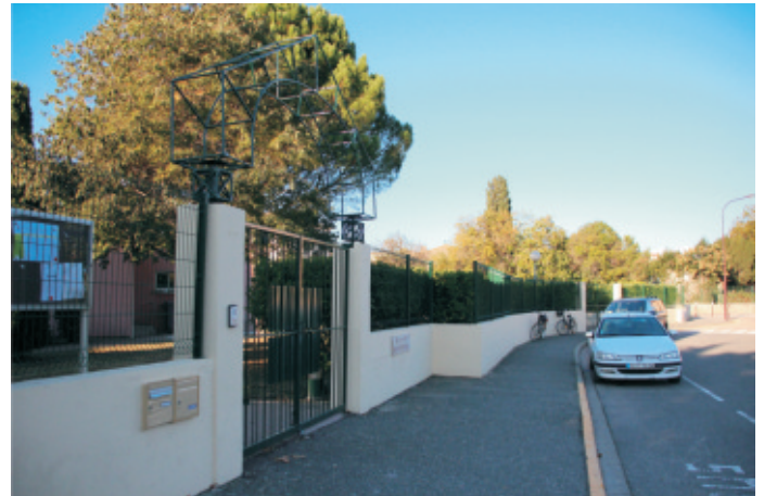
Le mur de l'école avec sa clôture grillagée
